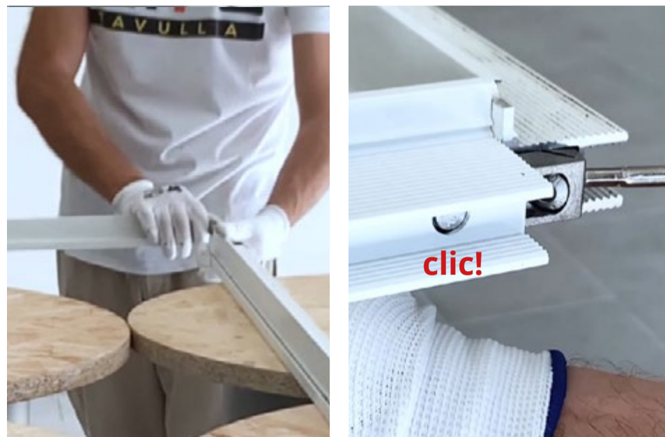
Inserire il traverso sui montanti tramite le squadrette. Insert the upper section brackets on jambs.
