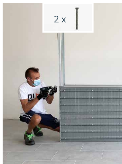
Fissa la guida con due viti come da immagine. Fix the guide using two long screws as shown in image.
