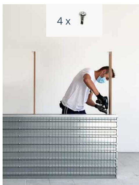
Posiziona i distanziali e fissali con due viti ciascuno. Place both spacer bars and fix each bar with 2 screws.
