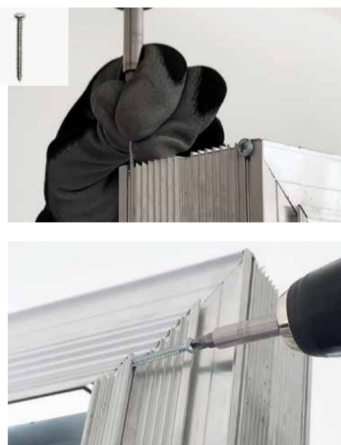
Fissa il montante con le 4 viti mostrate nelle immagini. Procede with jamb fixing using 4 screws as shown here.
