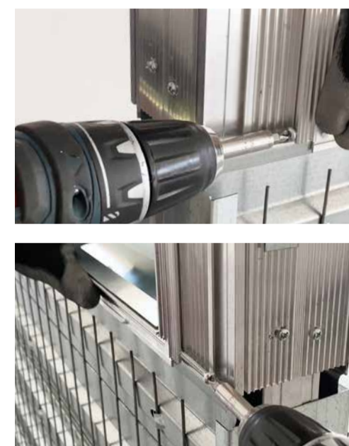
Fissa la guida con due viti come da immagine. Fix the guide using two long screws as shown in image.
