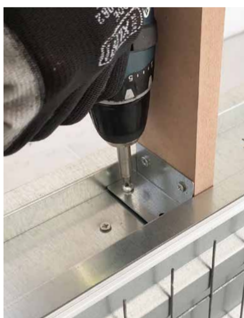
Posiziona i distanziali e fissali con due viti ciascuno. Place both spacer bars and fix each bar with 2 screws.
