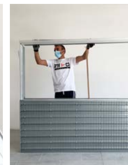
Inserisci le squadrette e posiziona il montante. Insert small brackets at the jamb end. Then place it.
