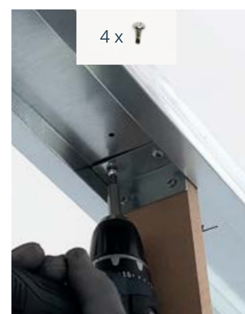
Posiziona e fissa le squadre su entrambi i lati. Termina fissando entrambi i distanziali al montante. Place and fix big brackets on both sides. Finish fixing both spacer bars to the jamb.
