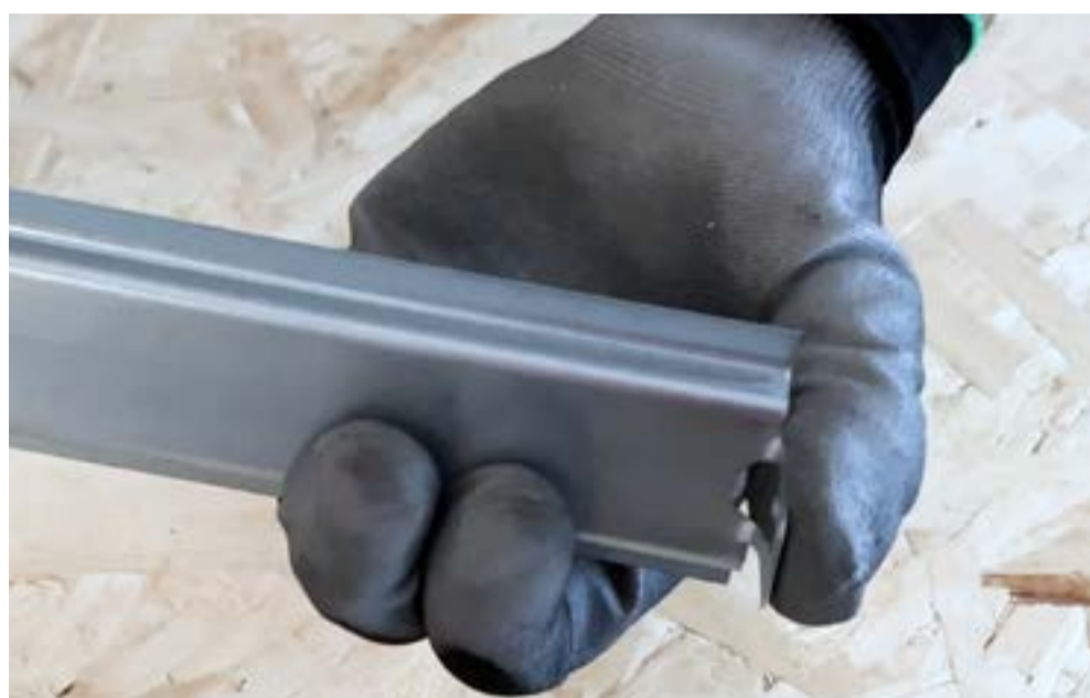
Piegare a 90° l'estremità di entrambi i distanziali. Fold 90° the end of both spacers.
